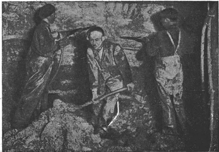
Проходка тоннеля в Охотном Броду.
