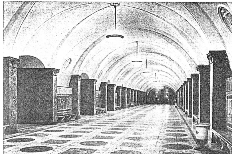
64. «Динамо». Центральный зал станции.
