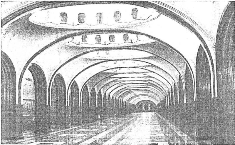
57. «Маяковская». Станционный зал.
