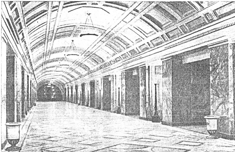
61. «Белорусская». Центральный зал станции.
