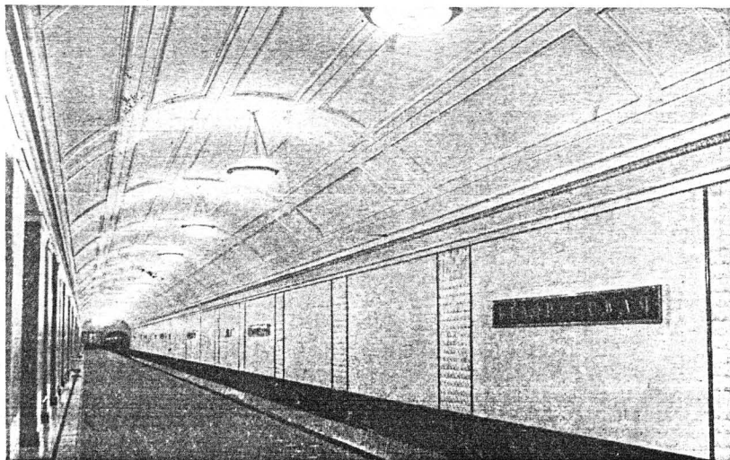
62. «Белорусская». Перронный зал станции.
