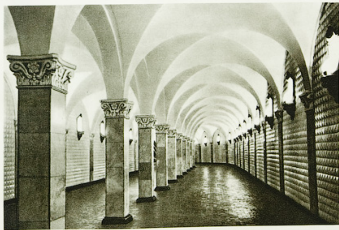
Коридор, ведущий от эскалаторов вестибюля к станции „Комсомольская“ (кольцевая)
