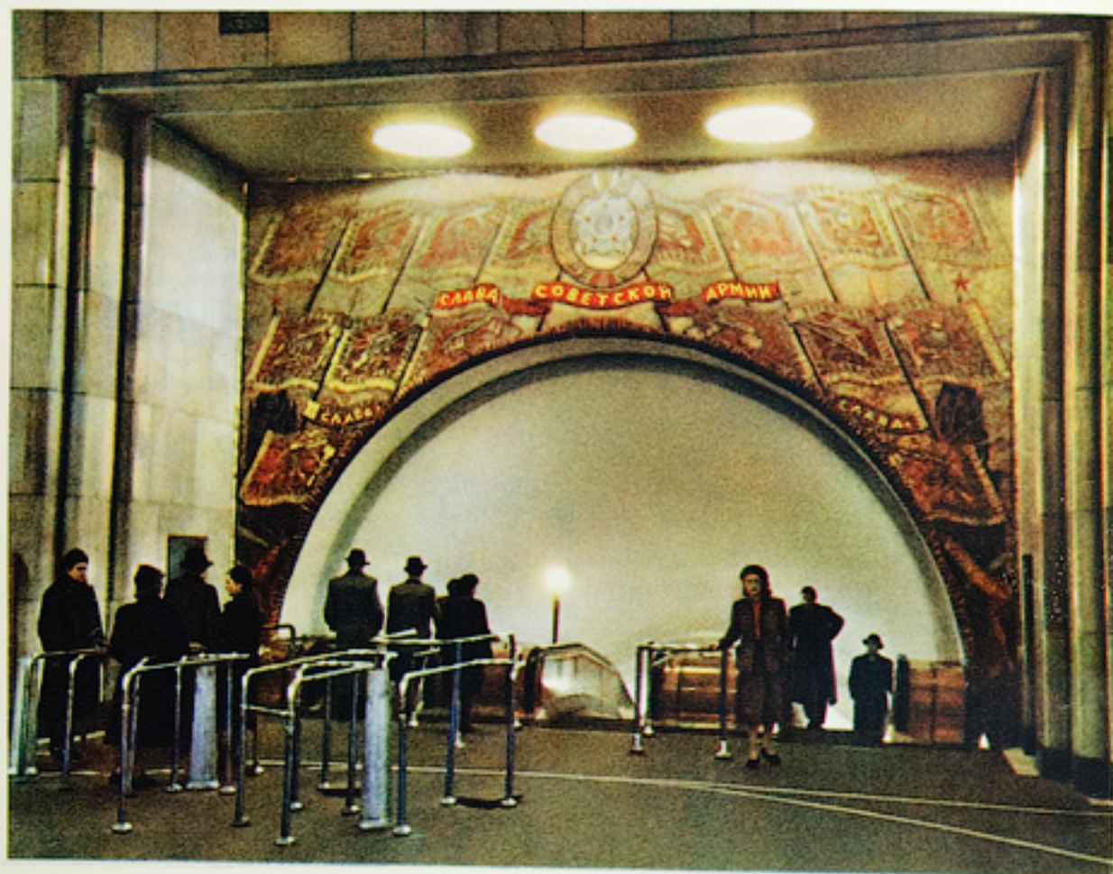
Вход на эскалаторы станции „Бауманская“
