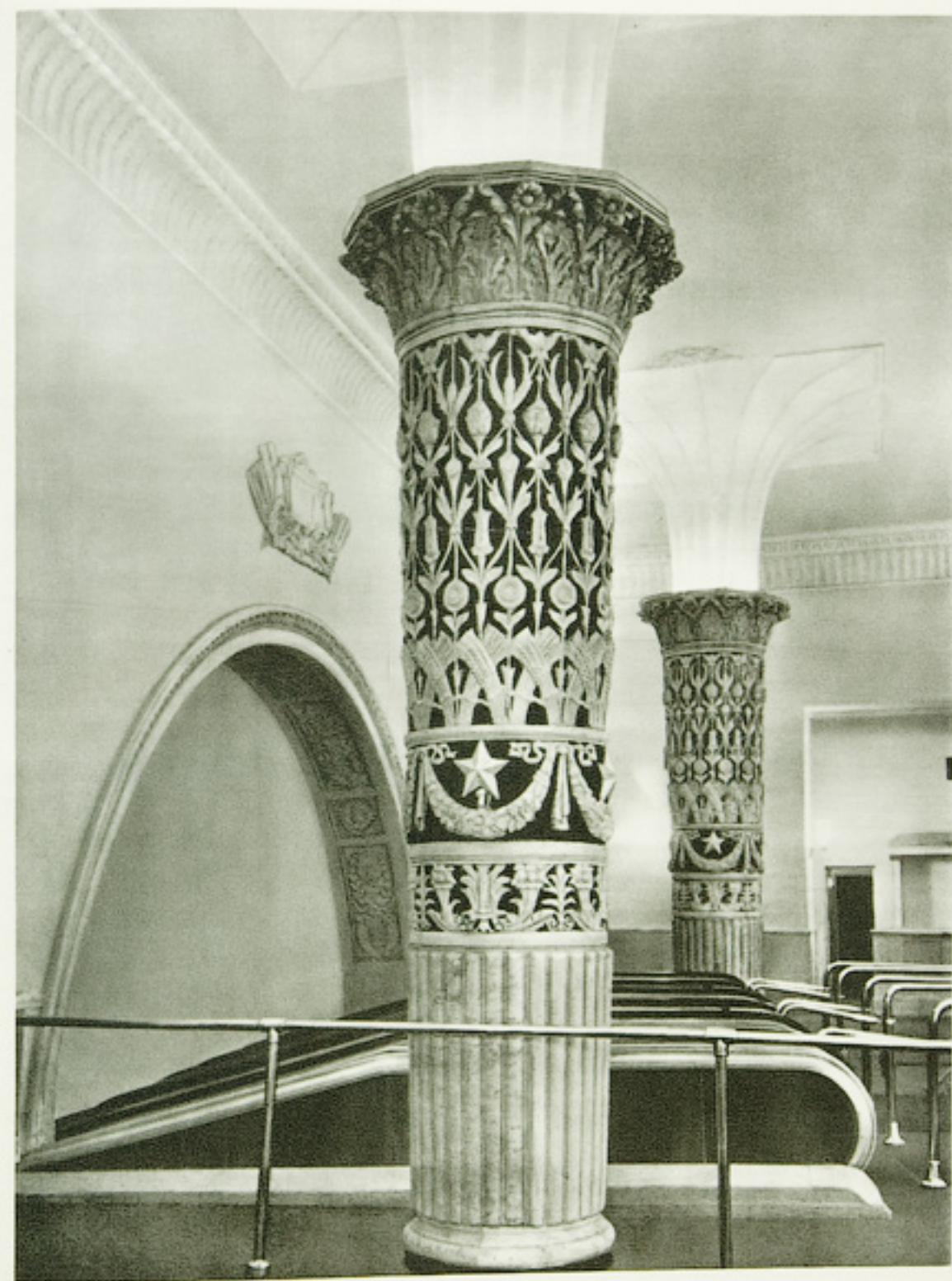
Внутренний вид вестибюля станции „Ботанический сад“
