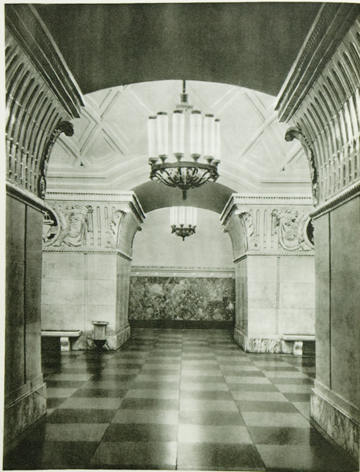
Проходы с посадочных платформ в центральный зал станции „Ботанический сад“
