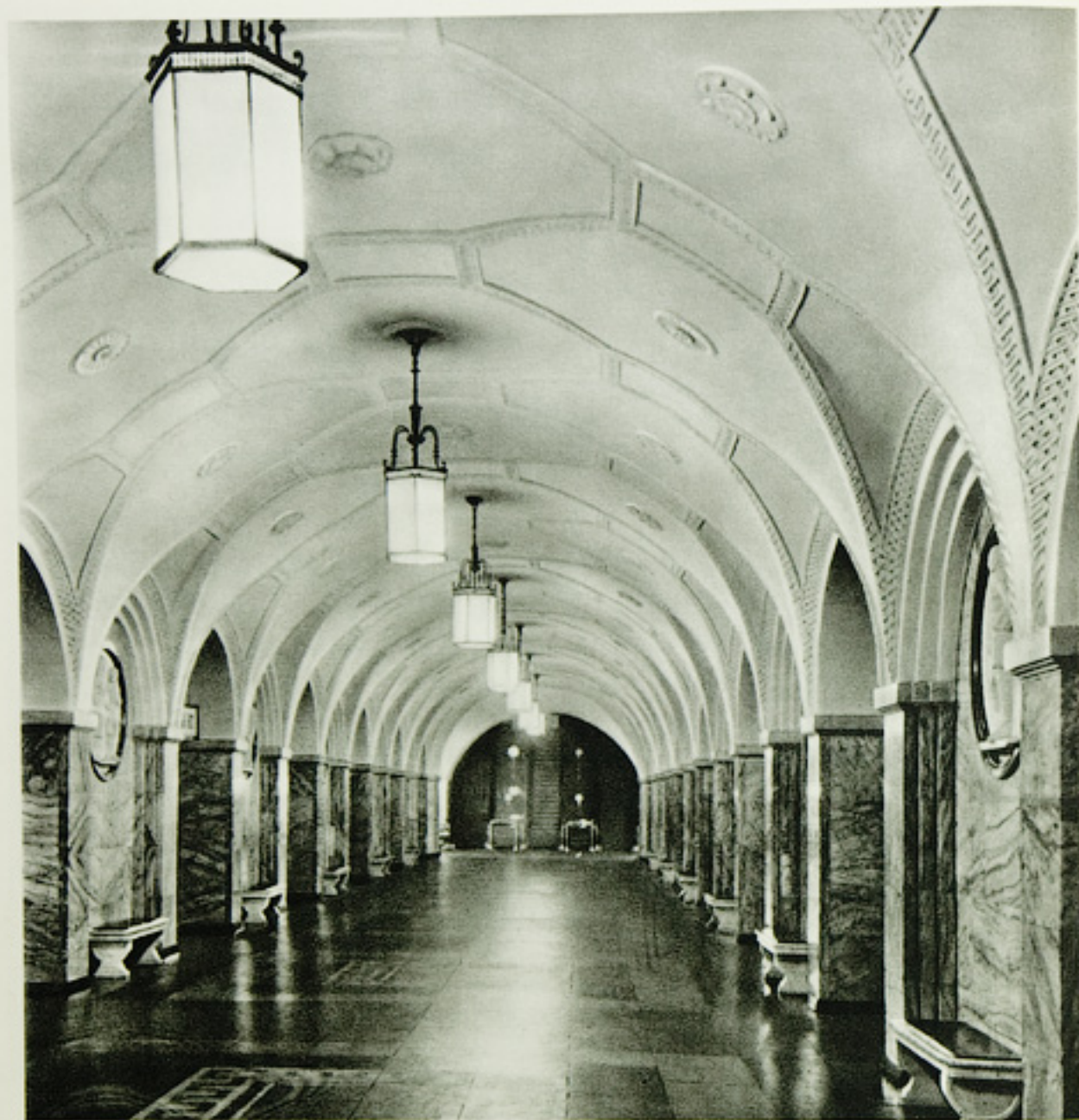
Центральный зал станции
