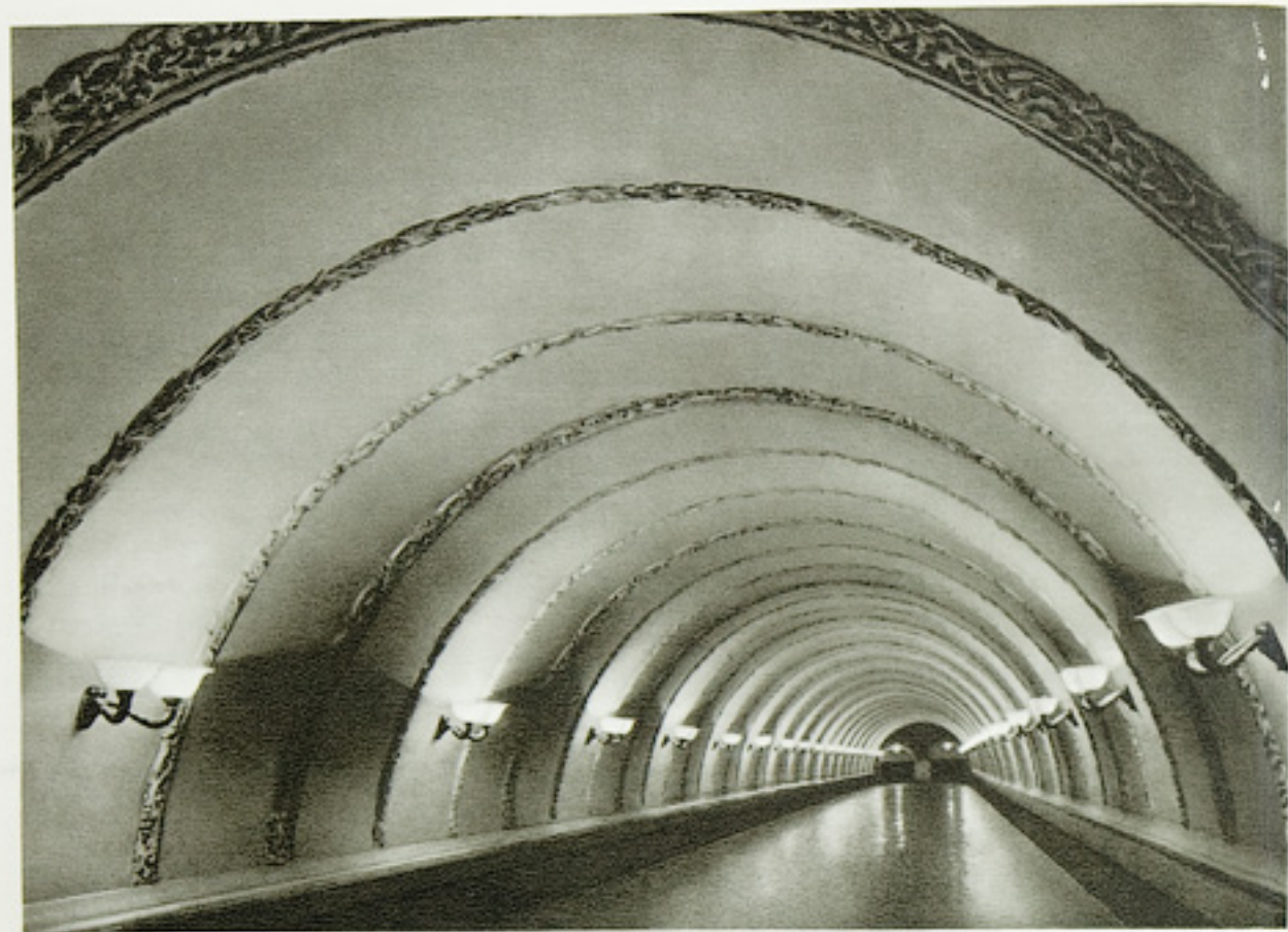
Переход, ведущий на станцию „Площадь Свердлова“
