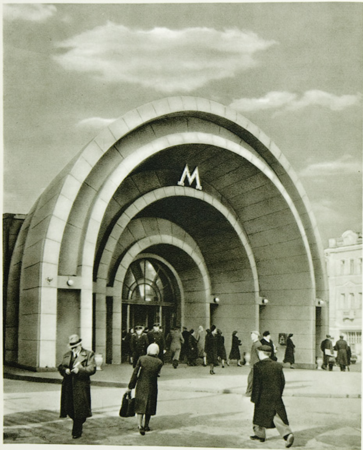
Станция „Красные ворота“ Архитектор Н. А. Лодовский
