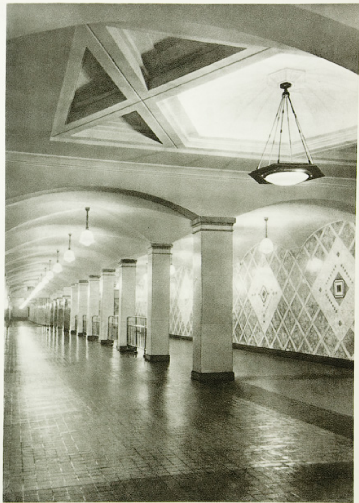
Коридор, ведущий к посадочным платформам станции „Сокол“
