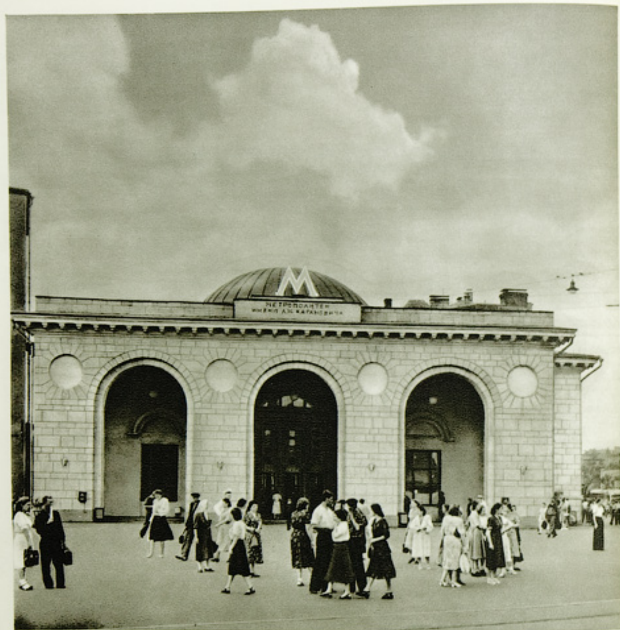
Станция „Центральный парк культуры и отдыха“
