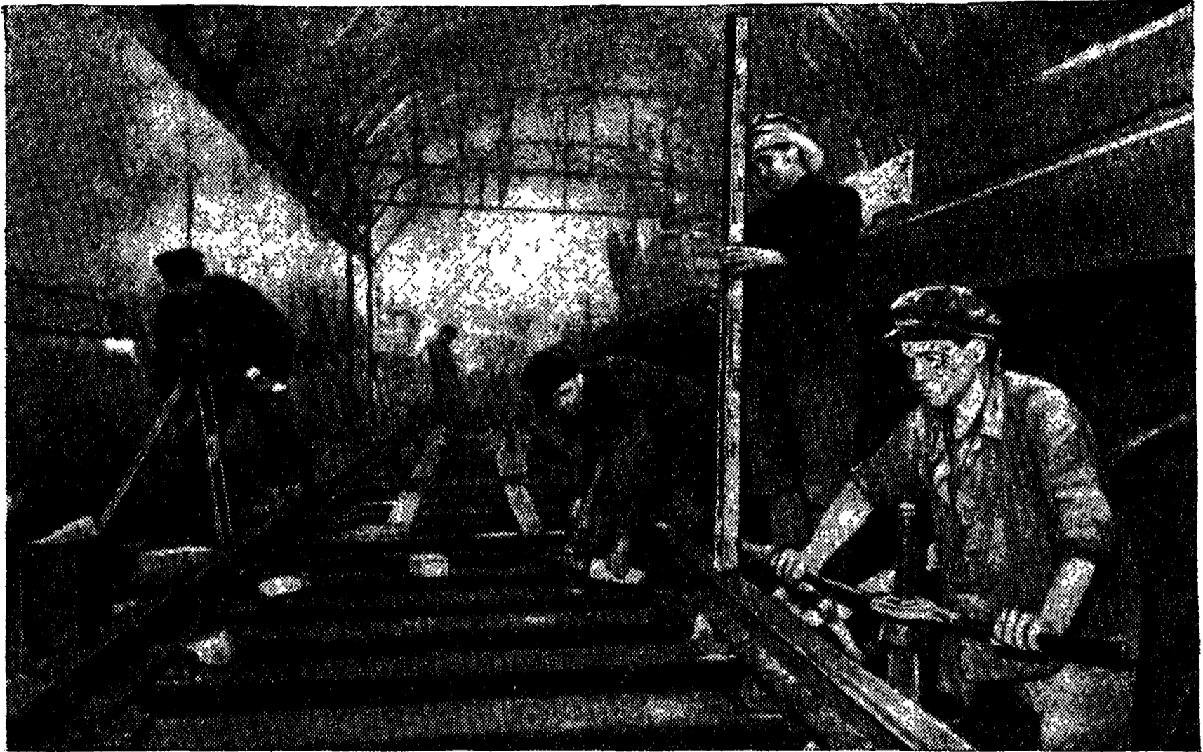
Рис. 147. Укрепление пути распорными домкратами
